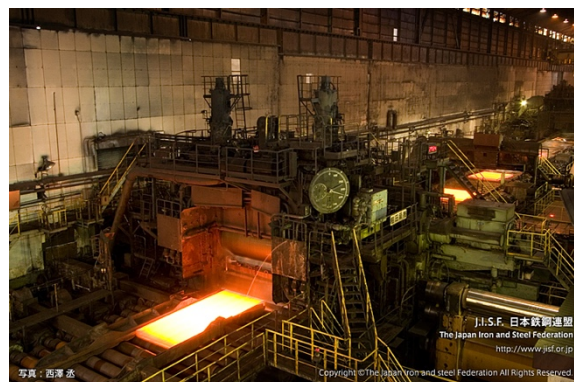
図6：鋼材再加熱炉の制御
